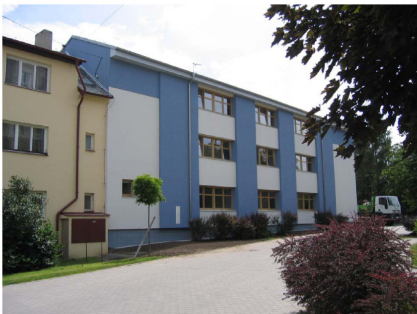
DPS Horní Počernice – rekonstrukce objektu
